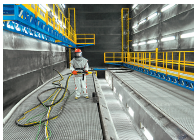
Дробеструйная камера с подъёмными площадками
