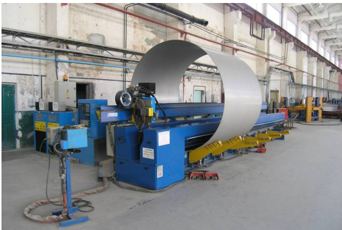
Стенд сварки обечаек
