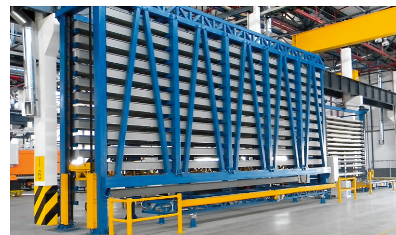
Автоматизований склад профільного металопрокату
