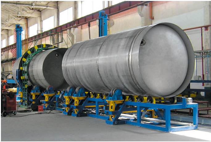
Лінія збирання та зварювання котла
