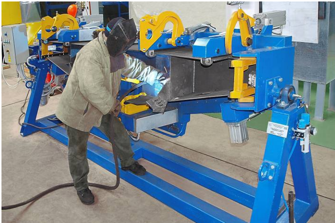
Стенд складання кінцевих балок напіввагонів
