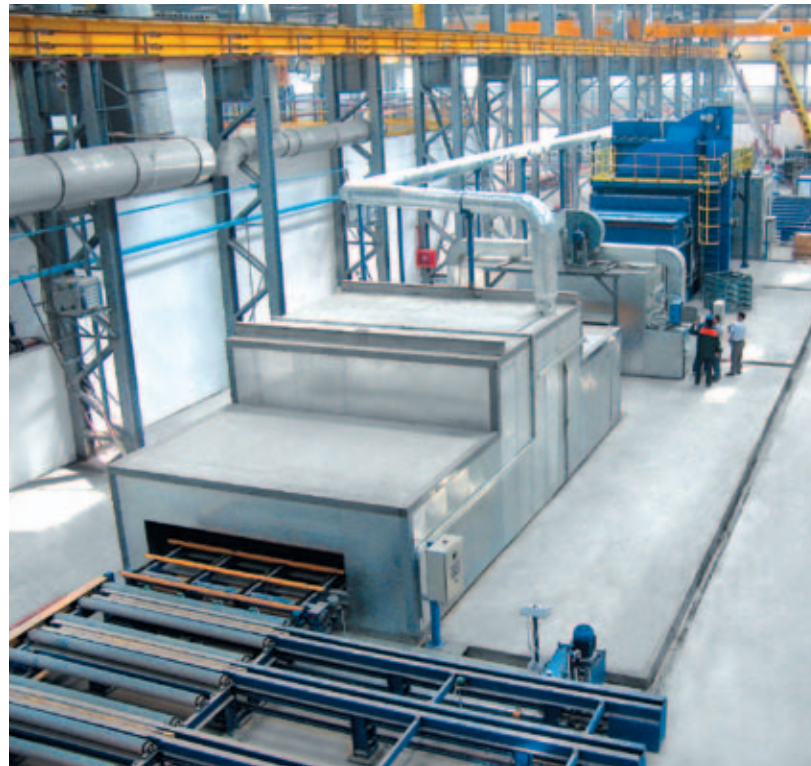
Линия очистки и консервации металлопроката
